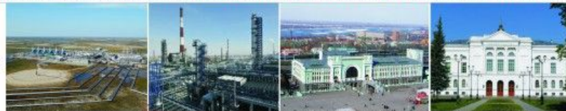
Установка комплексной подготовки газа на Ямбургском месторождении
