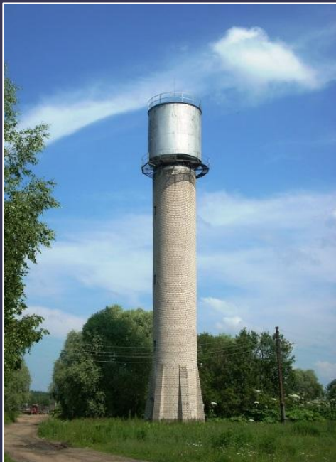
Водонапорная башня д. Ручьи
