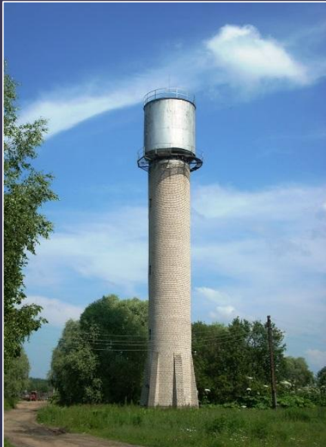
Водонапорная башня д. Ручьи
