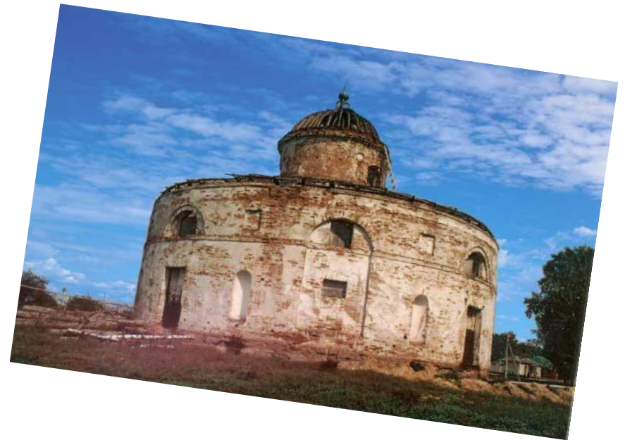
Здание в Грайворонском районе.
