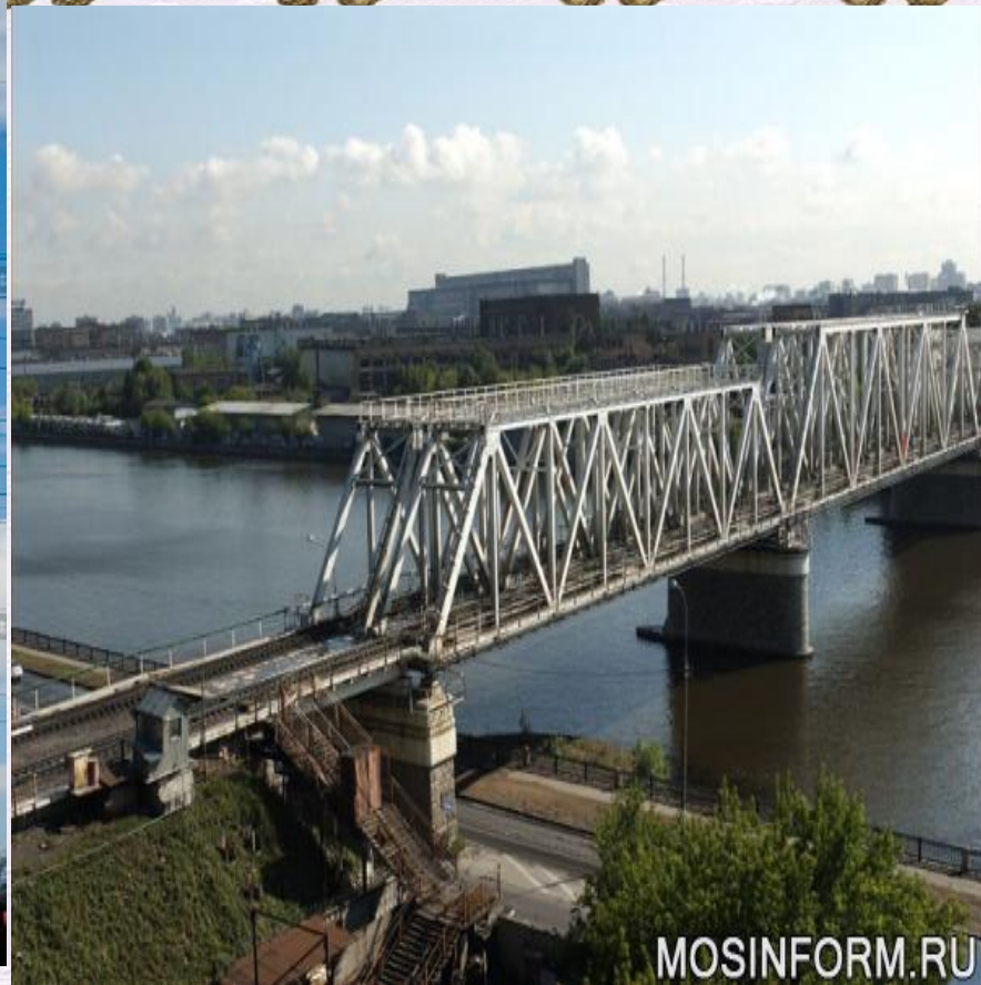
Треугольники в конструкции мостов.
