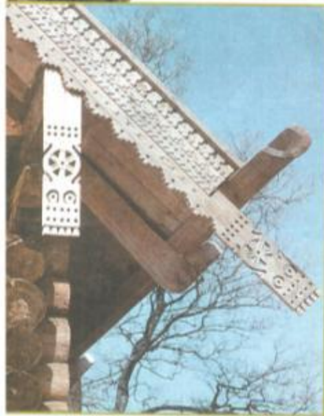
Резные причелина и полотенце избы, жёлоб (водосток). XIX в.
