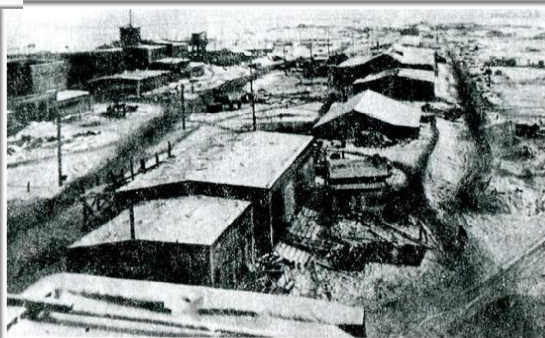
Общий вид строительства завода. 1931.
