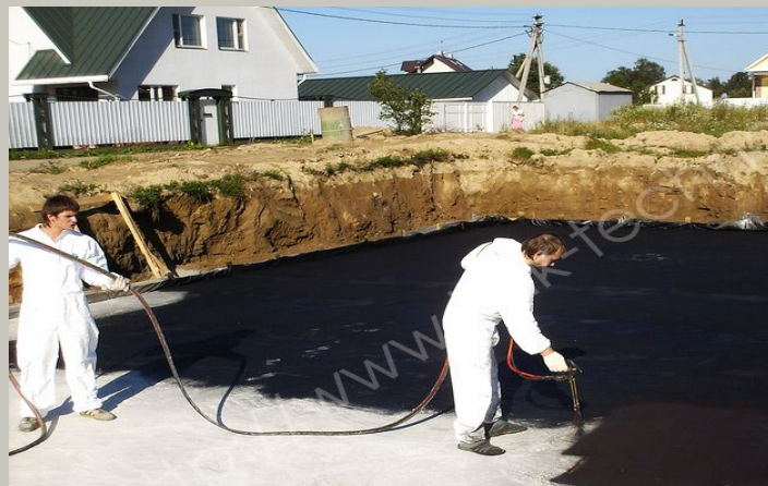
Жидкая резина применяется для гидроизоляции фундамента.
