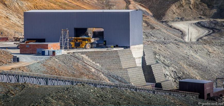
Разрыхлённую породу, огромные машины привозят на «Гирационную дробилку» производительностью 4 тысяч тонн руды в час.
