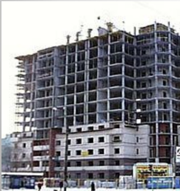
Дом из бетонных панелей
