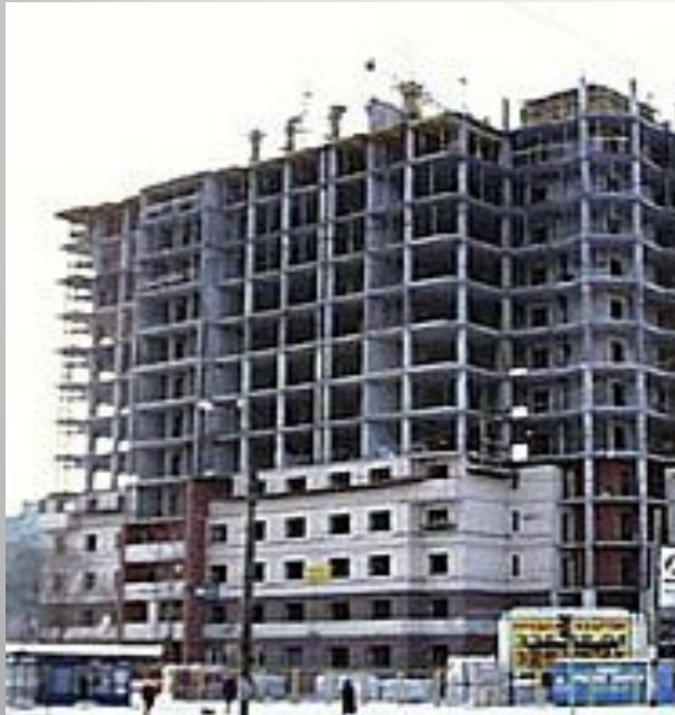
Дом из бетонных панелей
