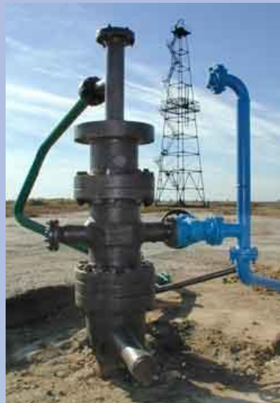
Выщелачивание через буровые скважины.
