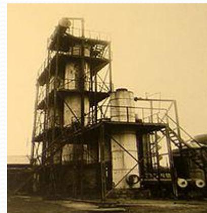
**РИФОРМИНГ** (от англ. reform – переделывать, улучшать) – каталитический промышленный процесс переработки определенных фракций нефти с целью получения высокооктанового бензина
