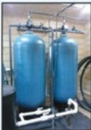
Установка для умягчения воды
