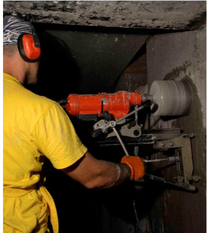
Сверление бетона
