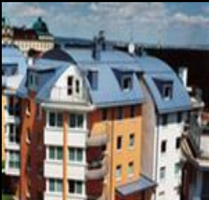
- Фальцевая кровля из алюминия.
