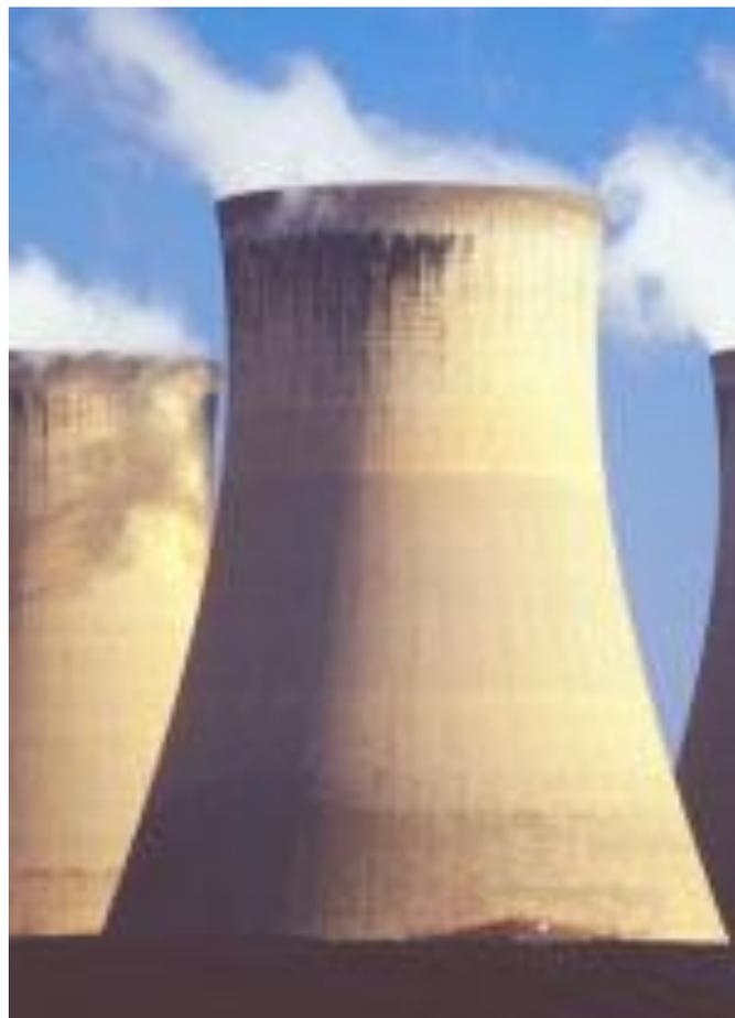
Градирни применяются в системах оборотного водоснабжения для охлаждения теплообменных аппаратов, в том числе на ТЭЦ и АЭС.
