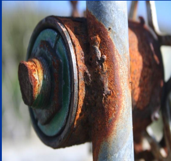
Ржавление железа – медленная реакция.
