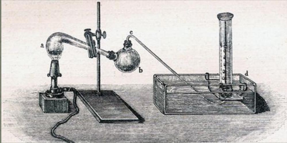
Получение кислорода из оксида ртути (реторта a) методом Пристли. В шарообразном сосуде b скапливается ртуть, а кислород по газоотводной трубке с переходит в цилиндр d, где собирается над жидкой ртутью.
