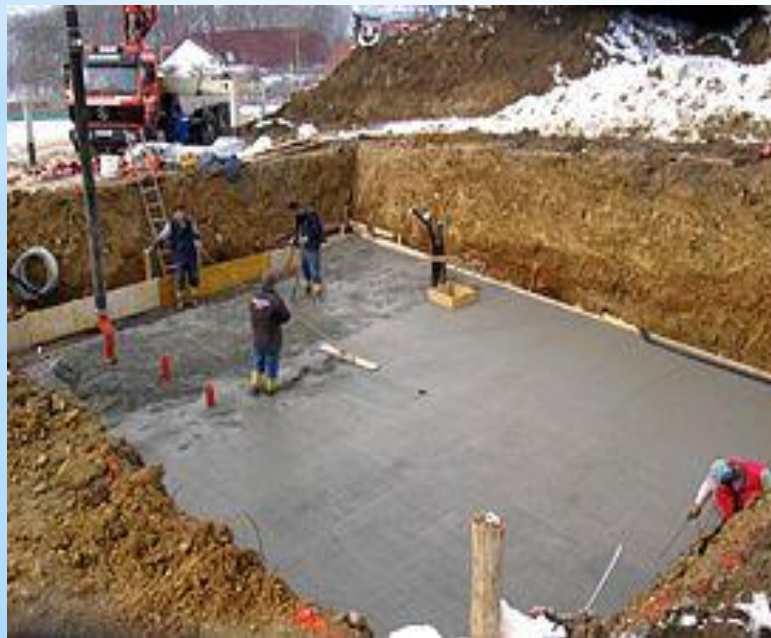
Укладка бетонной смеси
