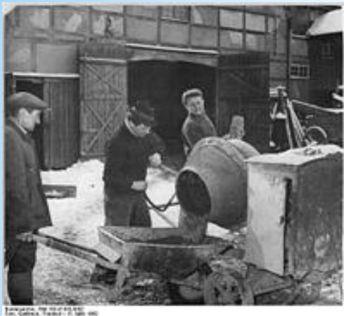
Раствор цемента перегружают в тележку
