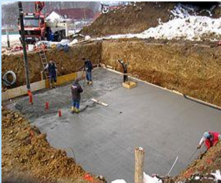
Укладка бетонной смеси
