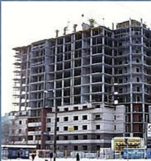
Дом из бетонных панелей
