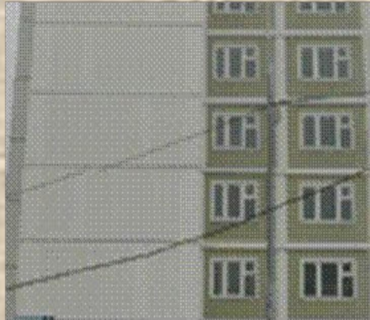
Жилое здание серии КОПЭ с 3-х слойными панелями, следующего состава: наружный слой панели из пластического бетона толщиной 60мм, внутренний слой из жесткого бетона толщиной 70мм, слой утеплителя между внутренним и наружным слоями – полистирольный пенопласт ПСБ 25 толщиной 120мм.
