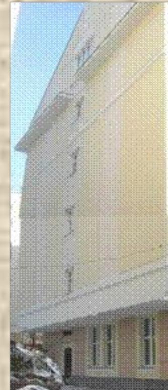
Состав стен: пеноблоки 200мм; утеплитель Rockwool 200 (160) мм; лицевой кирпич 120мм;
