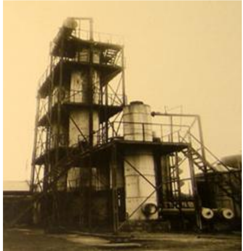
Установка термического крекинга В.Г.Шухова, Баку, СССР, 1934
