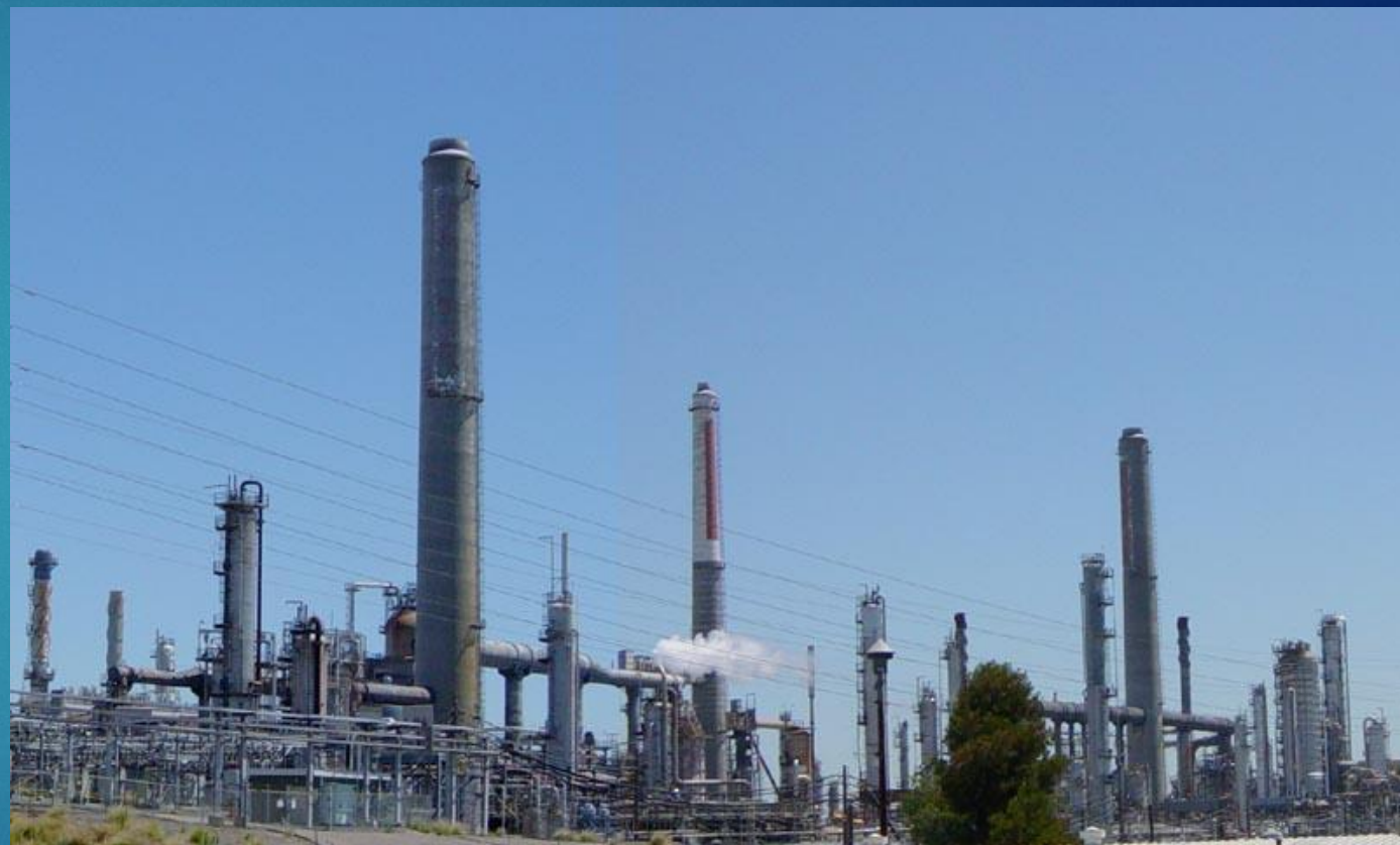
Нефтеперерабатывающий завод компании Shell в Калифорнии
