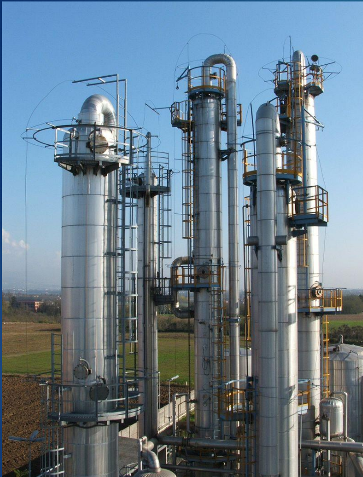
Промышленные ректификационные колонны
