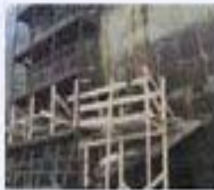
Стройматериалы и грунт под зданием 60
