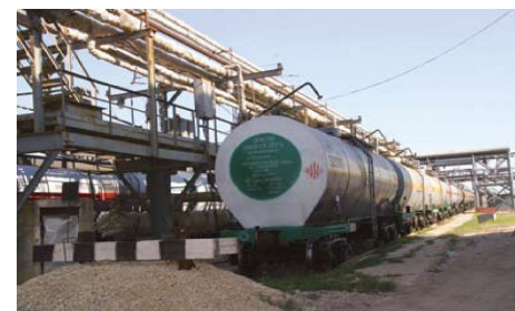
Сұйық күкіртті темір жол цистерналарына құю эстакадасы
