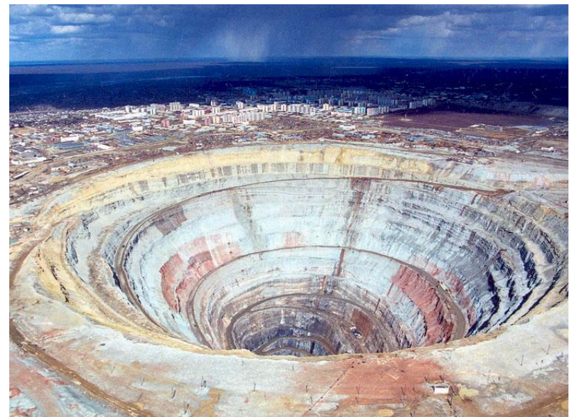
Кимберлитовая трубка “Мир” диаметр 1 500 м, глубина 500 м
