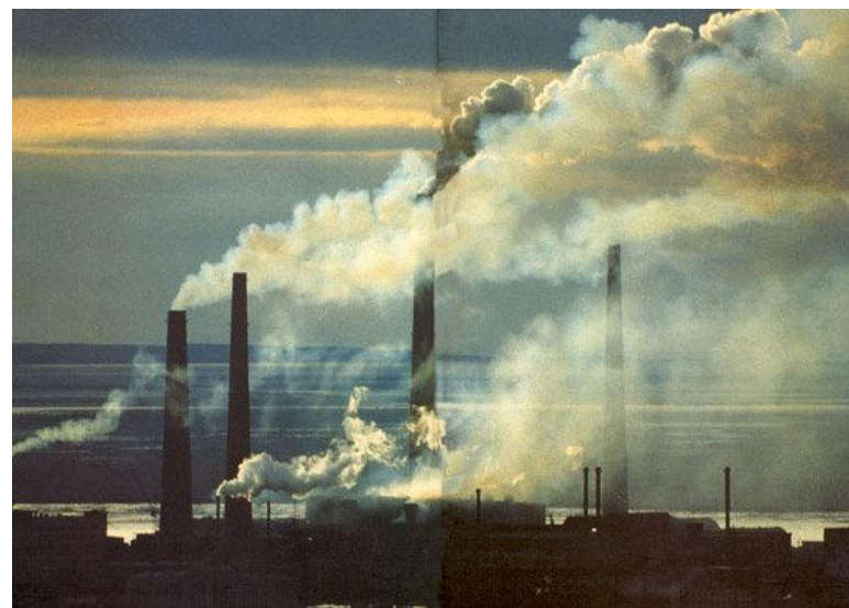
Норильский горно-металлургический комбинат
