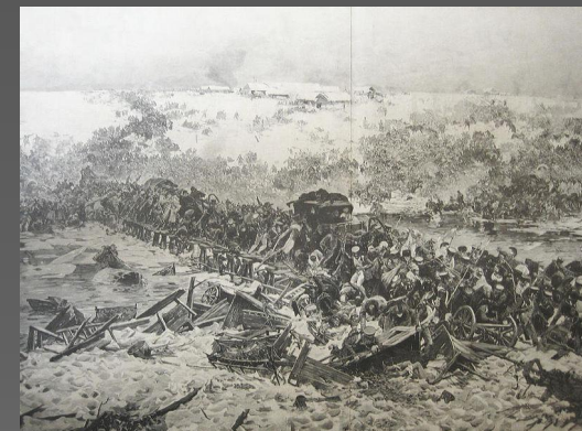
Мост через Березину
