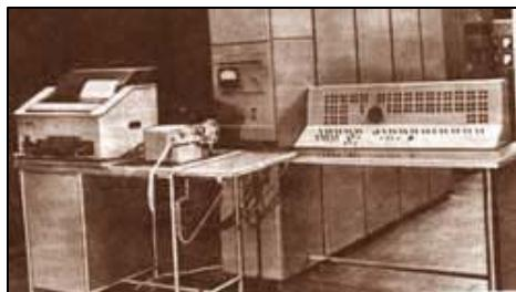
В 1959 г. выпущена отечественная вычислительная машина **Сетунь**, работающая в троичной системе счисления.
