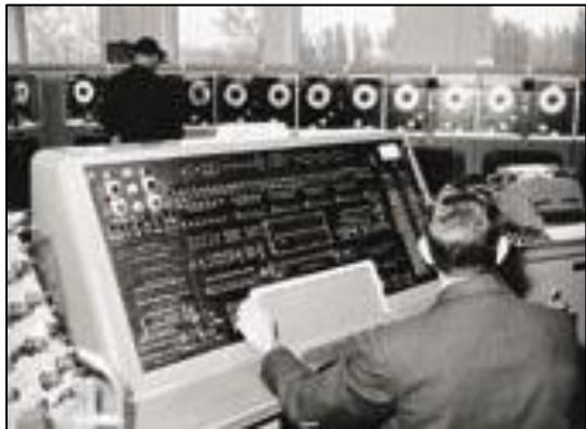
В 1951 году была закончена работа по созданию **UNIVAC** (Universal Automatic Computer). Первый образец машины UNIVAC-1 был построен для бюро переписи США. Синхронная, последовательного действия вычислительная машина UNIVAC-1 создана была на базе ЭВМ ENIAC и EDVAC.
