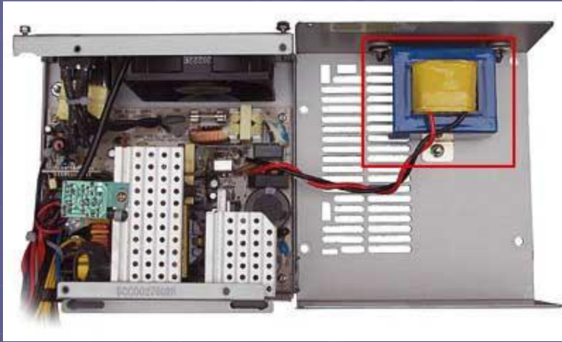
Дроссель пассивного PFC, смонтированный на крышке БП (FSP300-60BTV)
