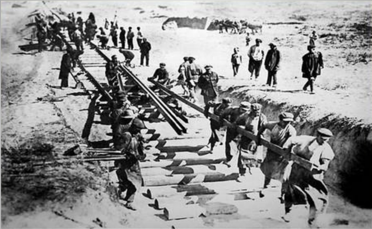
Укладка рельсов на Туркестано-Сибирской железной дороге
