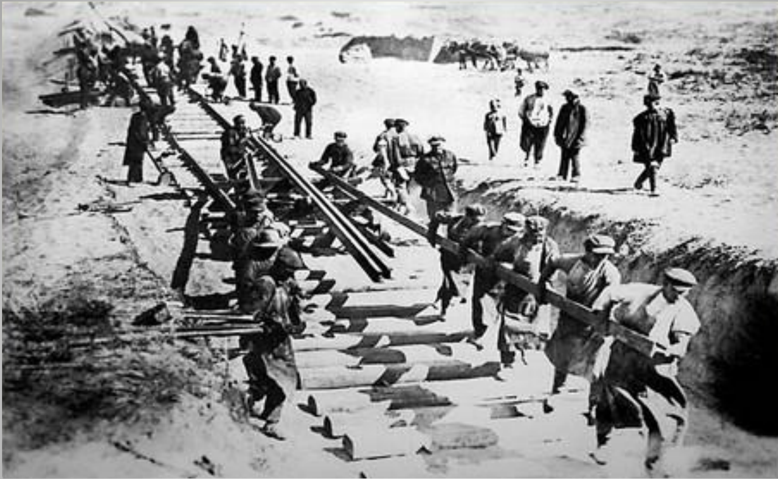
Укладка рельсов на Туркестано-Сибирской железной дороге
