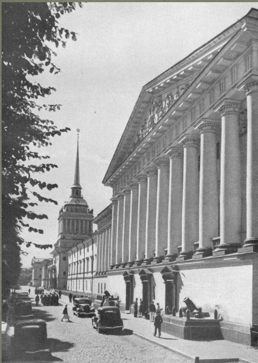
ГЛАВНЫЙ ФАСАД ЗДАНИЯ АДМИРАЛТЕЙСТВА.
