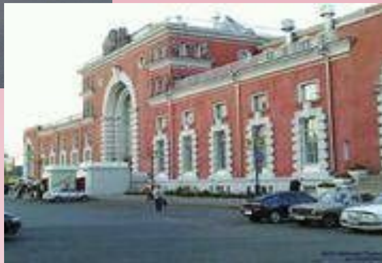
Здание железнодорожного вокзала г. Курска
