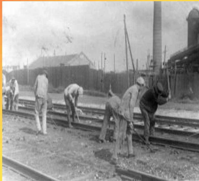
Восстановление железнодорожных путей
