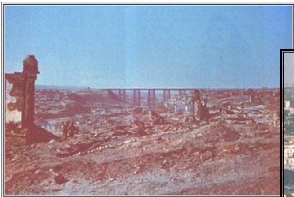
Разрушения в Сталинграде, октябрь 1942г.
