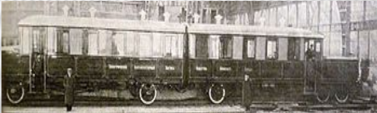
Сдвоенный пассажирский аккумуляторный моторный вагон производства Общества Брянского Завода, 1910 год.
