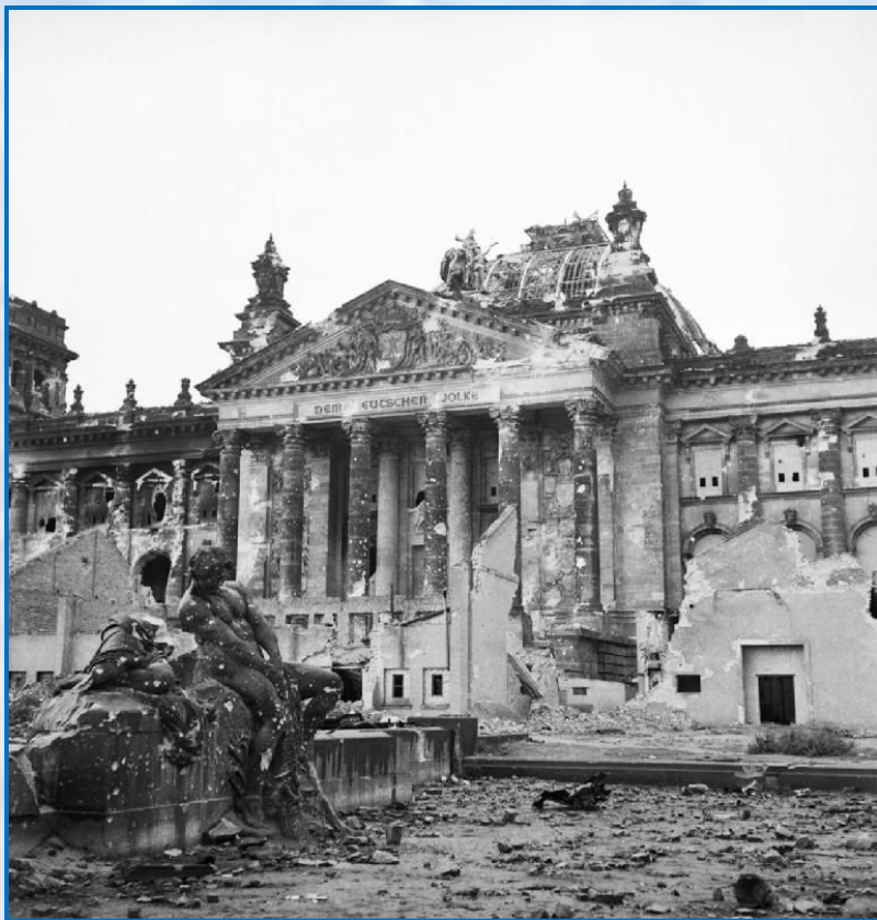
Западный фасад Рейхстага, 3 июня 1945 года. Над фронтоном центрального входа видна скульптурная группа «Германия», на которой штурмовая группа Макова в 22:30 30 апреля 1945 года водрузила красный флаг.
