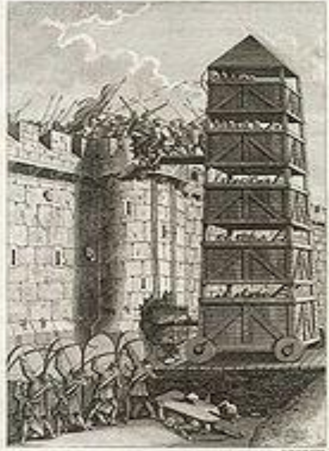
Колонна для разрушения стен.
