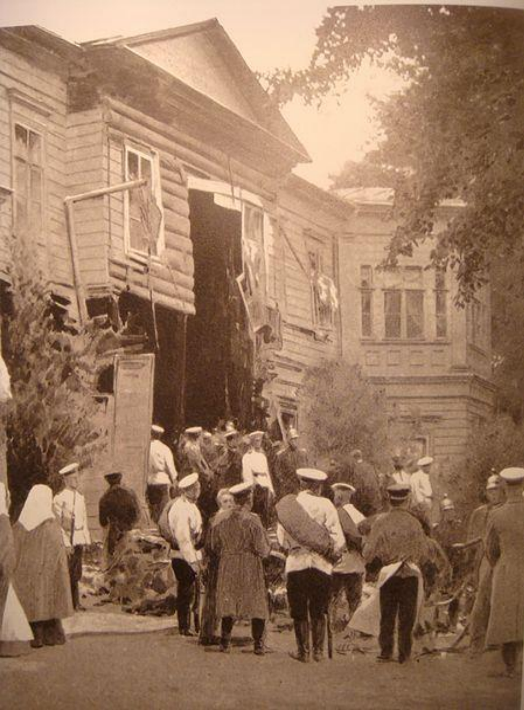
Разрушенное вследствие взрыва здание особняка Столыпина на Аптекарском острове
