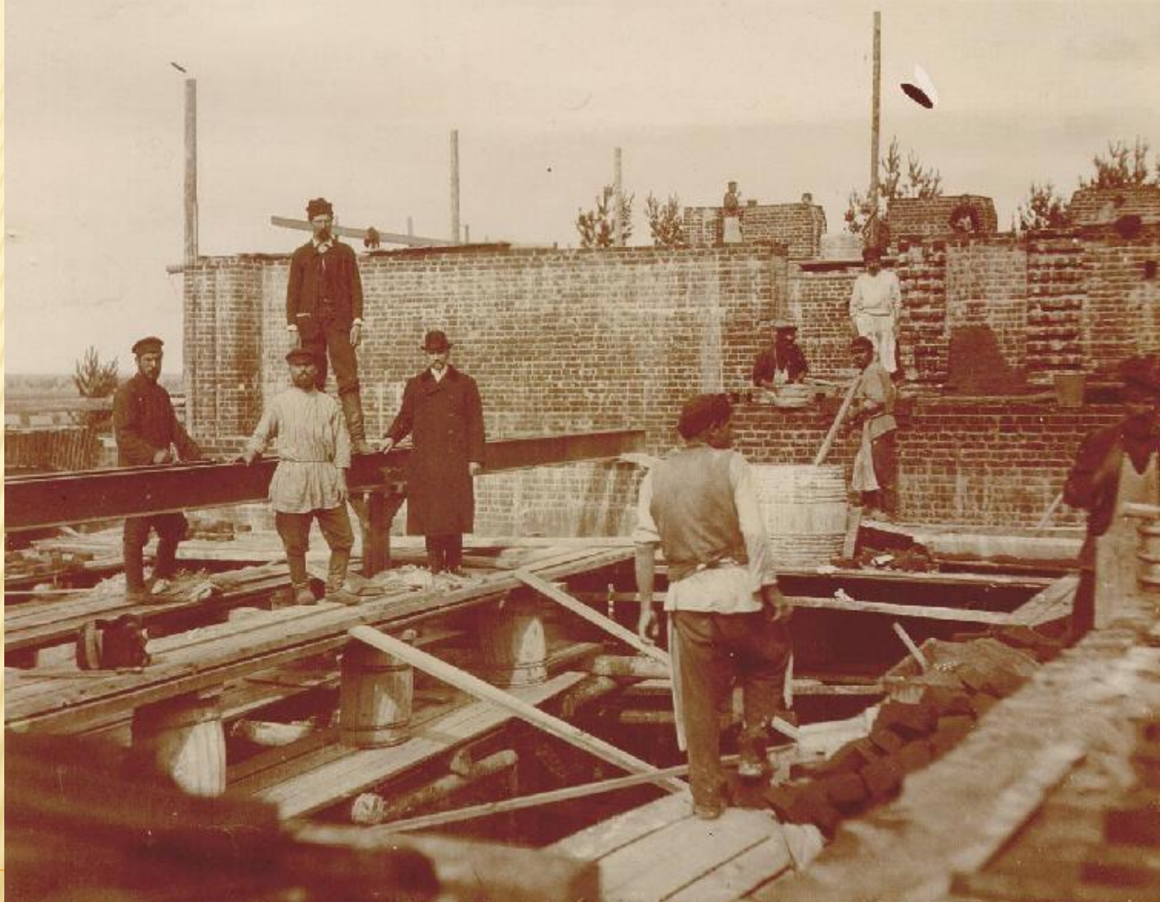
Строительство церкви Ярославских чудотворцев
