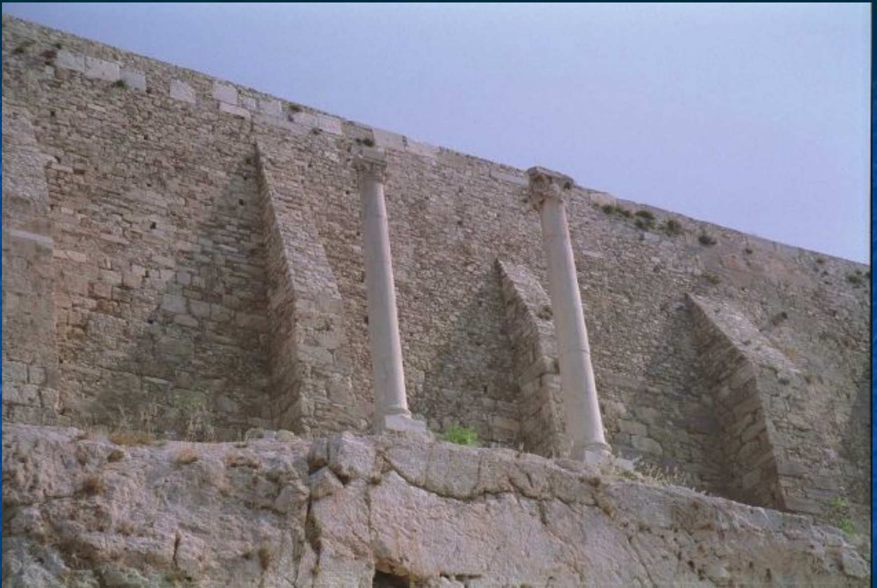
Каменная стена укрепления афинского Акрополя
