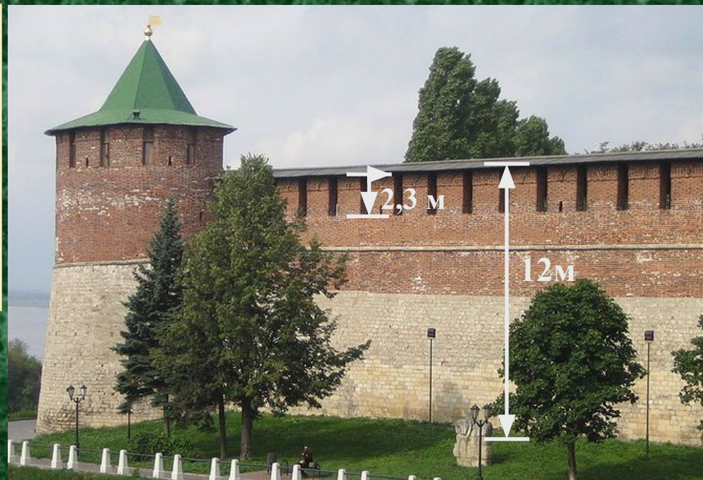
Поперечный профиль укреплённой линии Нижегородского кремля
