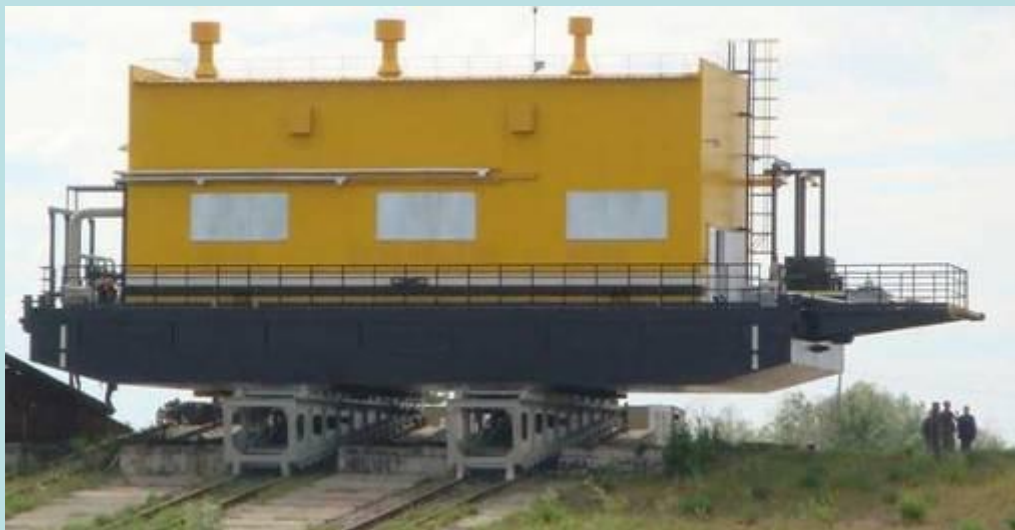
Плавучая насосная станция
