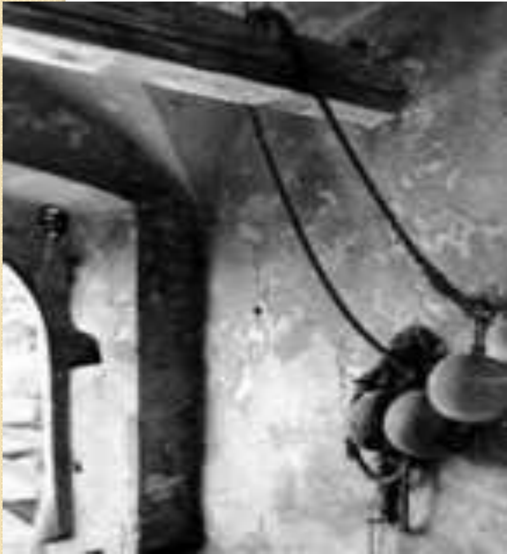
Противовесы на подъемнике ворот
