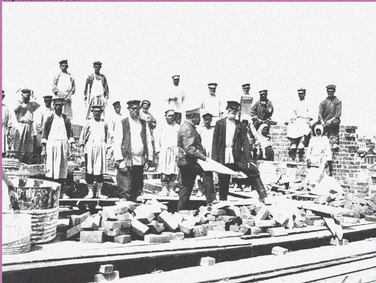
Архитектор А.А. Щербачев и заказчик Ю.И. Поплавский на строительстве, 1902 год. Из личного фонда Щербачевых в ЦГАСО
