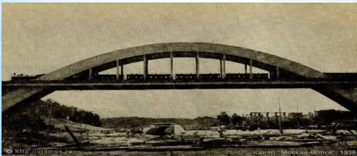
Строители сооружали над каналом бетонный четырехпутный мост Октябрьской железной дороги.
