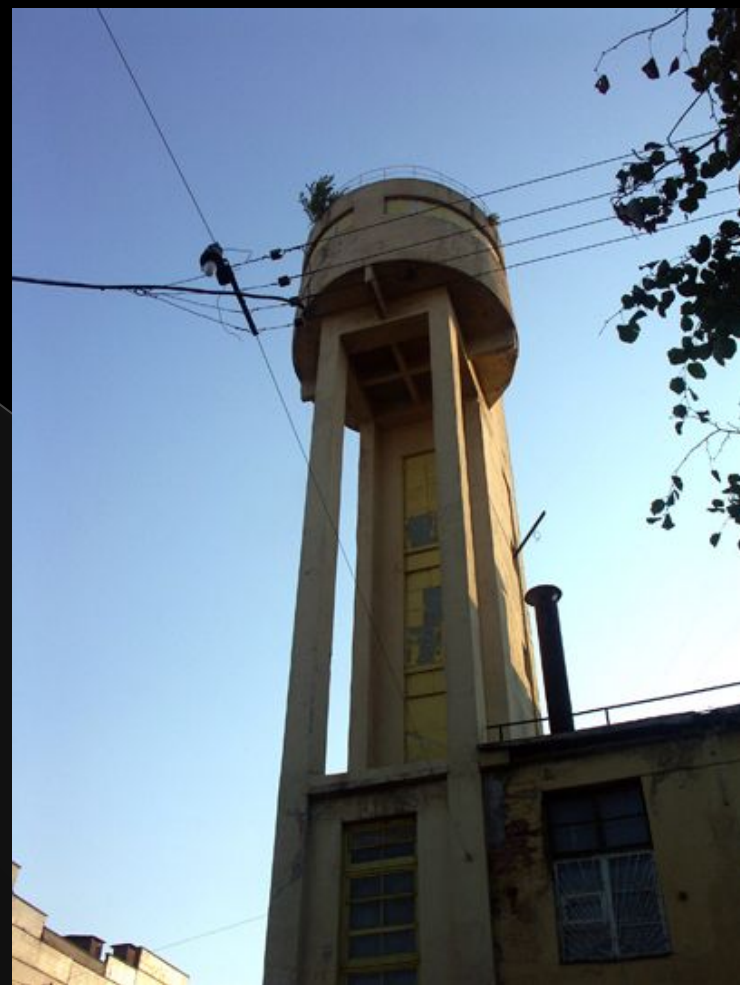
Я. Чернихов (1929–1930) Водонапорная башня завода «Красный Гвоздильщик»
