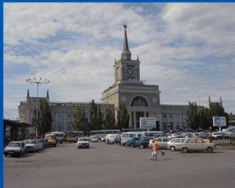
Вокзал на станции Волгоград-I
