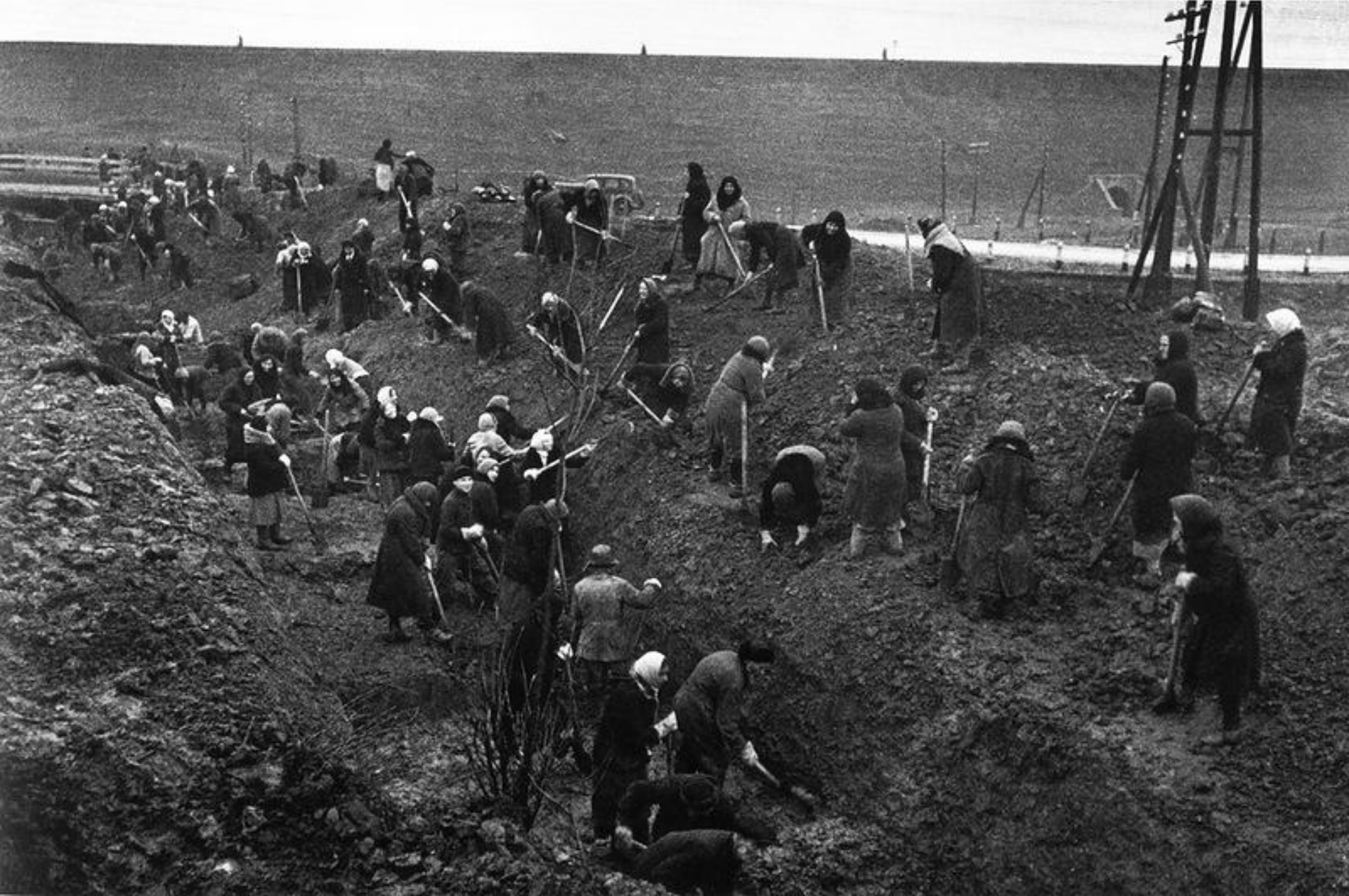
Женщины строят оборонительные укрепления под Москвой. Октябрь 1941г
