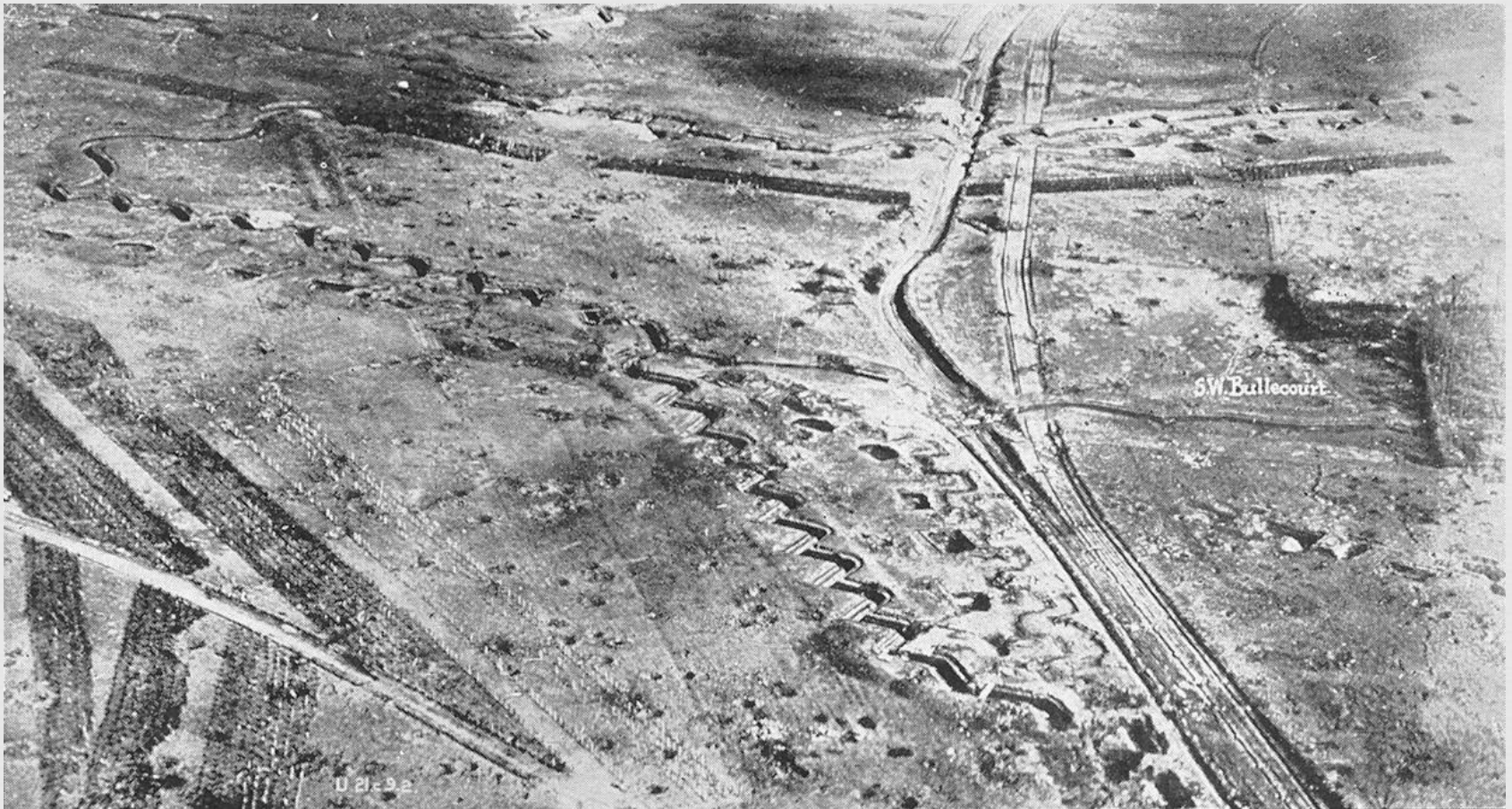
Линия Гинденбурга в районе Буллекурта (вид с воздуха)
