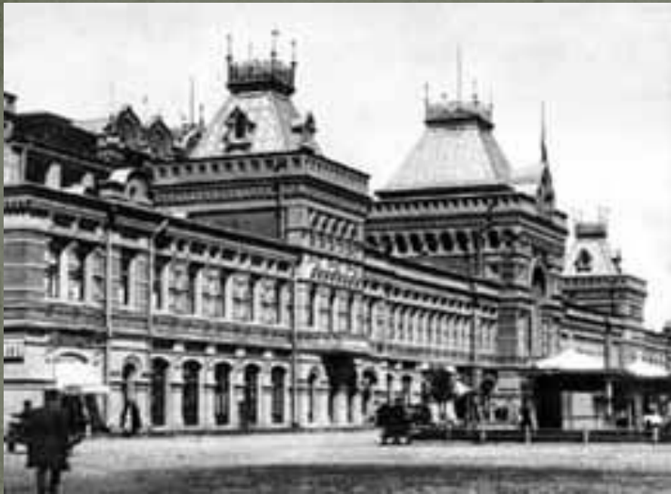
Вид на Главный дом с площади.
