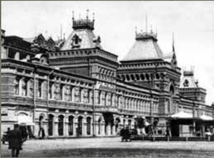
Вид на Главный дом с площади.
