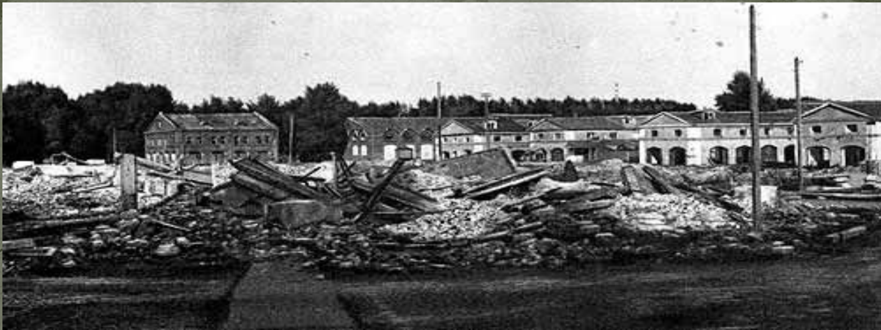
Вид на разрушенные Китайские ряды и пустующие корпуса около Спасского собора.
